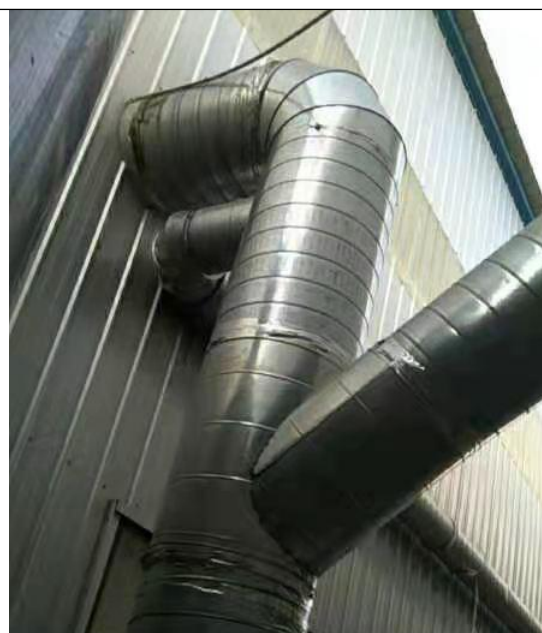
入喷淋罐合并管道
