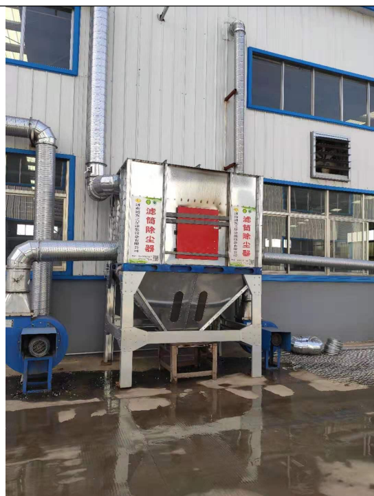
滤筒除尘器（焊接工序）
