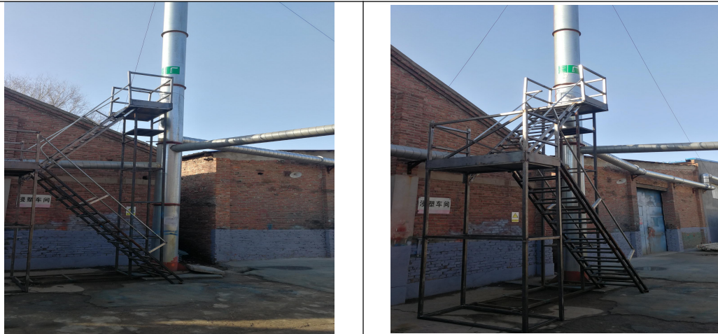
废气采样平台
